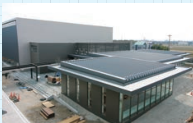
3号館から見る新食堂・第2体育館
